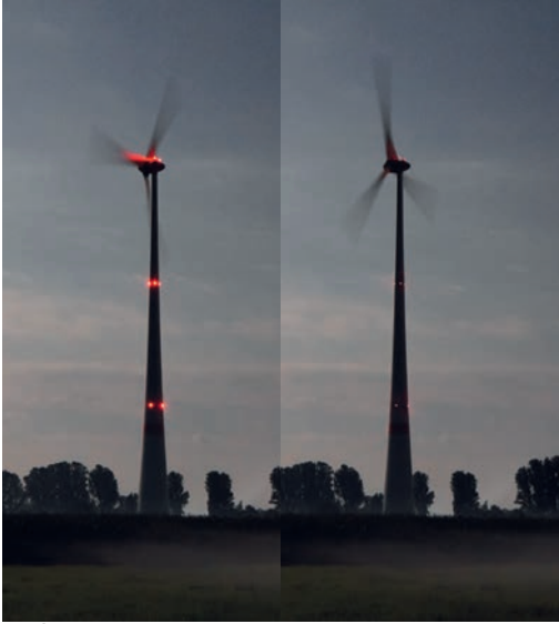
Befeuerungskonzept ARC-SIRIL Obstacle lighting concept ARC-SIRIL
